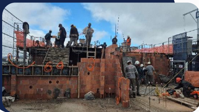
Foto 5: Andamento da obra
