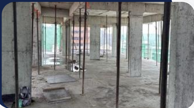
Foto 1: Reescoramento – 10º Pav.
