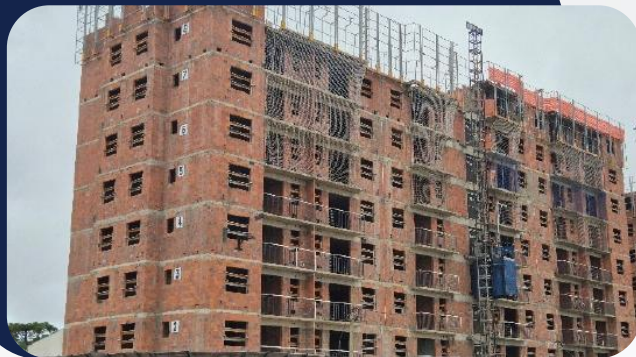
Foto 2: Andamento da obra
