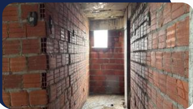
Foto 5: Alvenaria
