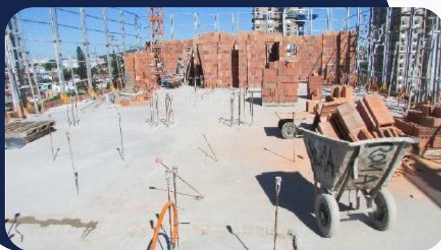
Foto 5: Andamento da obra
