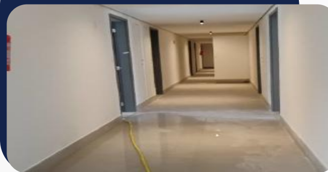
Foto 5: Limpeza do hall
