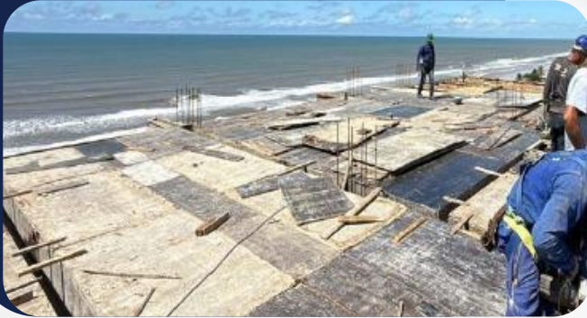
Foto 1: Forma 11º pavimento
