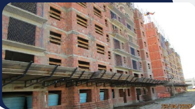
Foto 2: Andamento da obra
