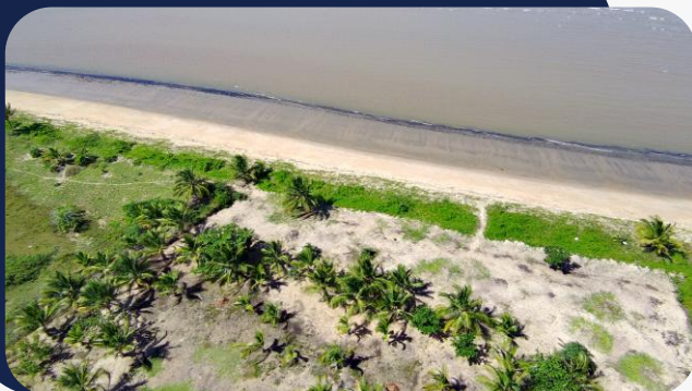
Foto 3: Acesso à praia
