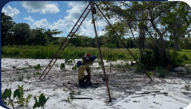
Foto 2: Sondagem do terreno
