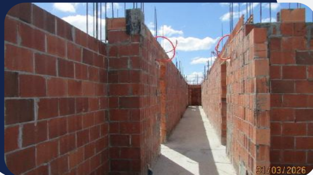
Foto 2: Andamento da obra
