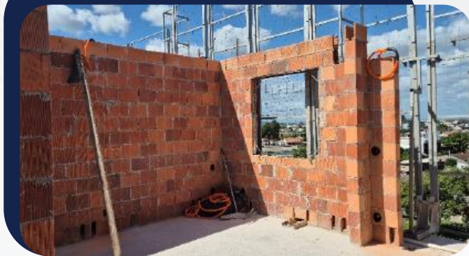
Foto 2: Andamento da obra
