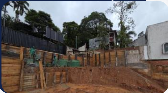
Foto 1: Muros de contenção
