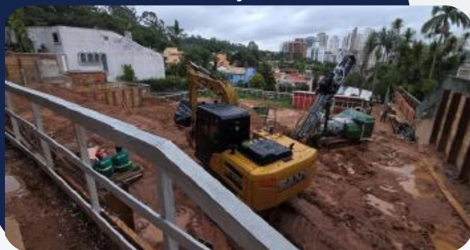
Foto 2 Movimentação de terra
