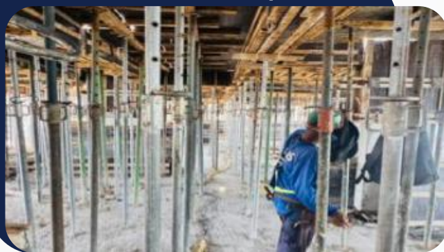
Foto 5: Escoramento 6º pavimento
