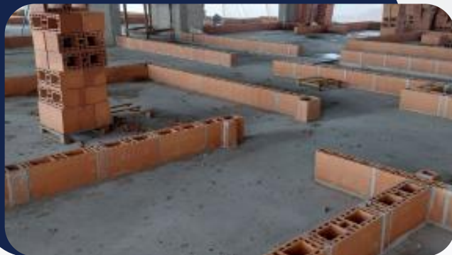
Foto 2: Marcação de alvenaria
