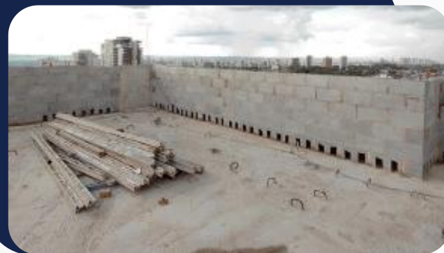
Foto 5: Platibandas na cobertura
