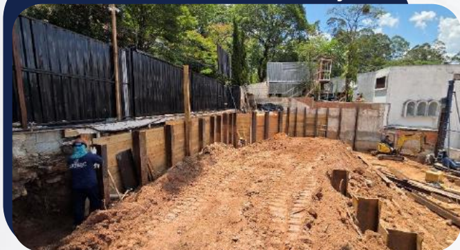
Foto 1: Cortinas de contenção
