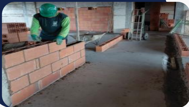
Foto 3: Elevação da alvenaria
