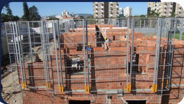
Foto 5: Andamento de Obra
