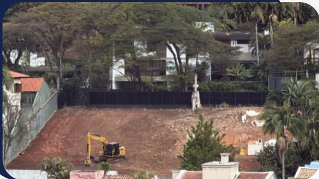
Foto 1: Limpeza do terreno
