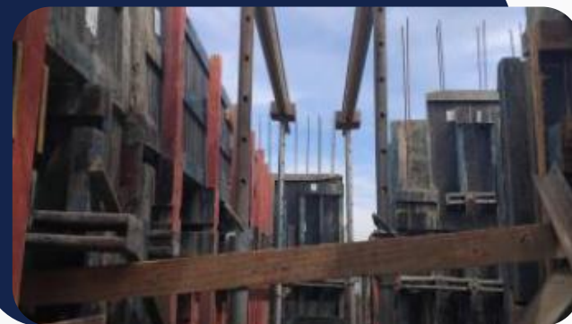
Foto 5: Pilares do 20º Pavimento
