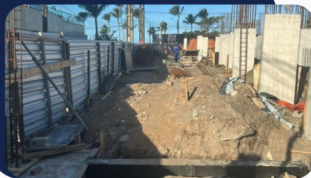
Foto 5: Visão da Obra
