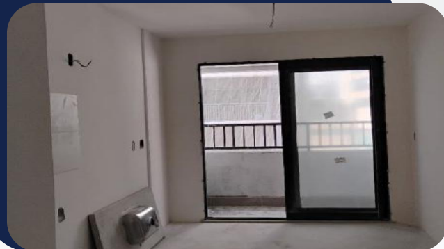
Foto 2: Instalação de portas
