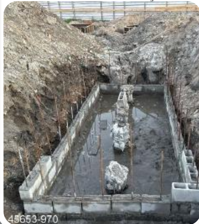
Avanço de obra Bloco de Fundação
