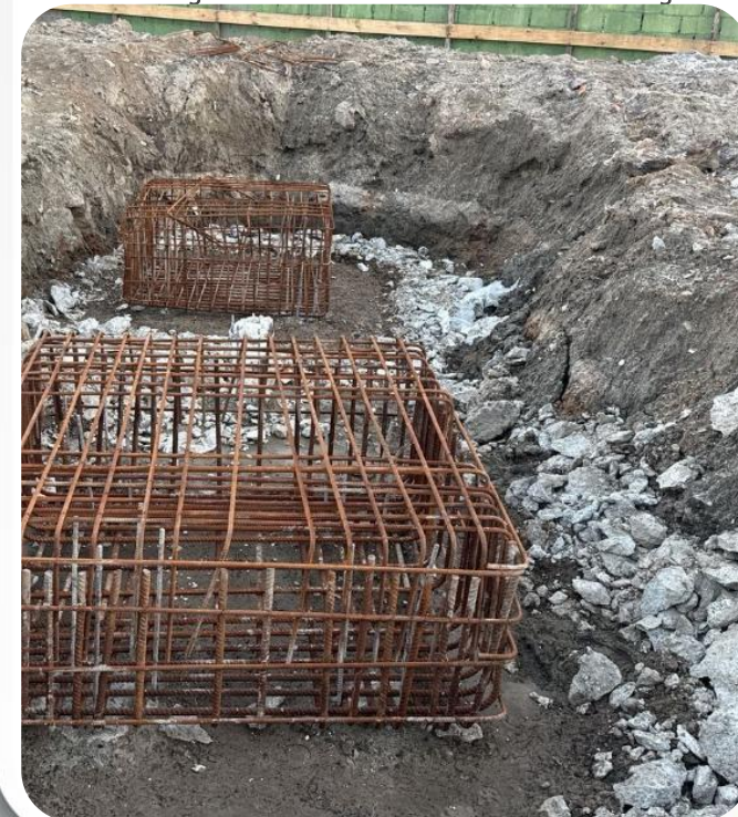
Avanço de obra Armação Bloco Fundação
