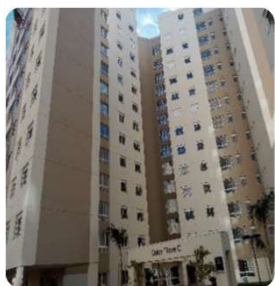
Fachada Torre C
